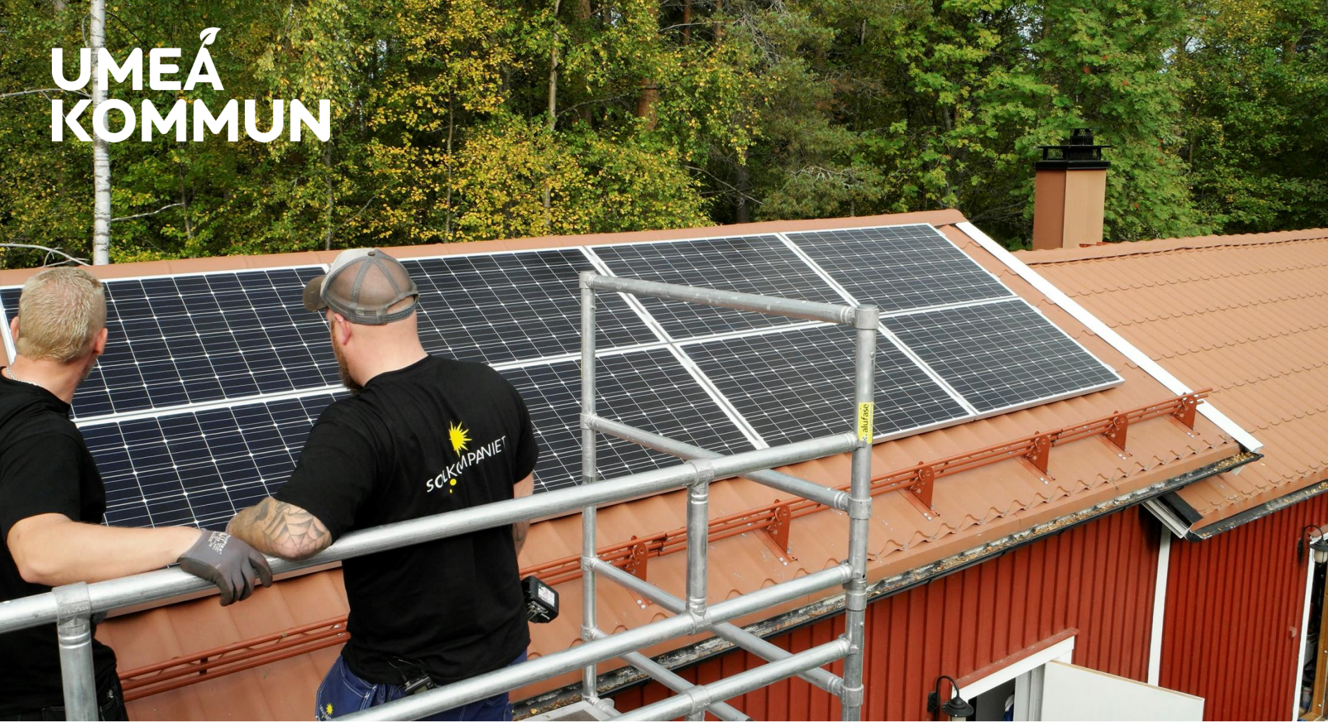
Foto: Solcellsinstallation i Täfteå
